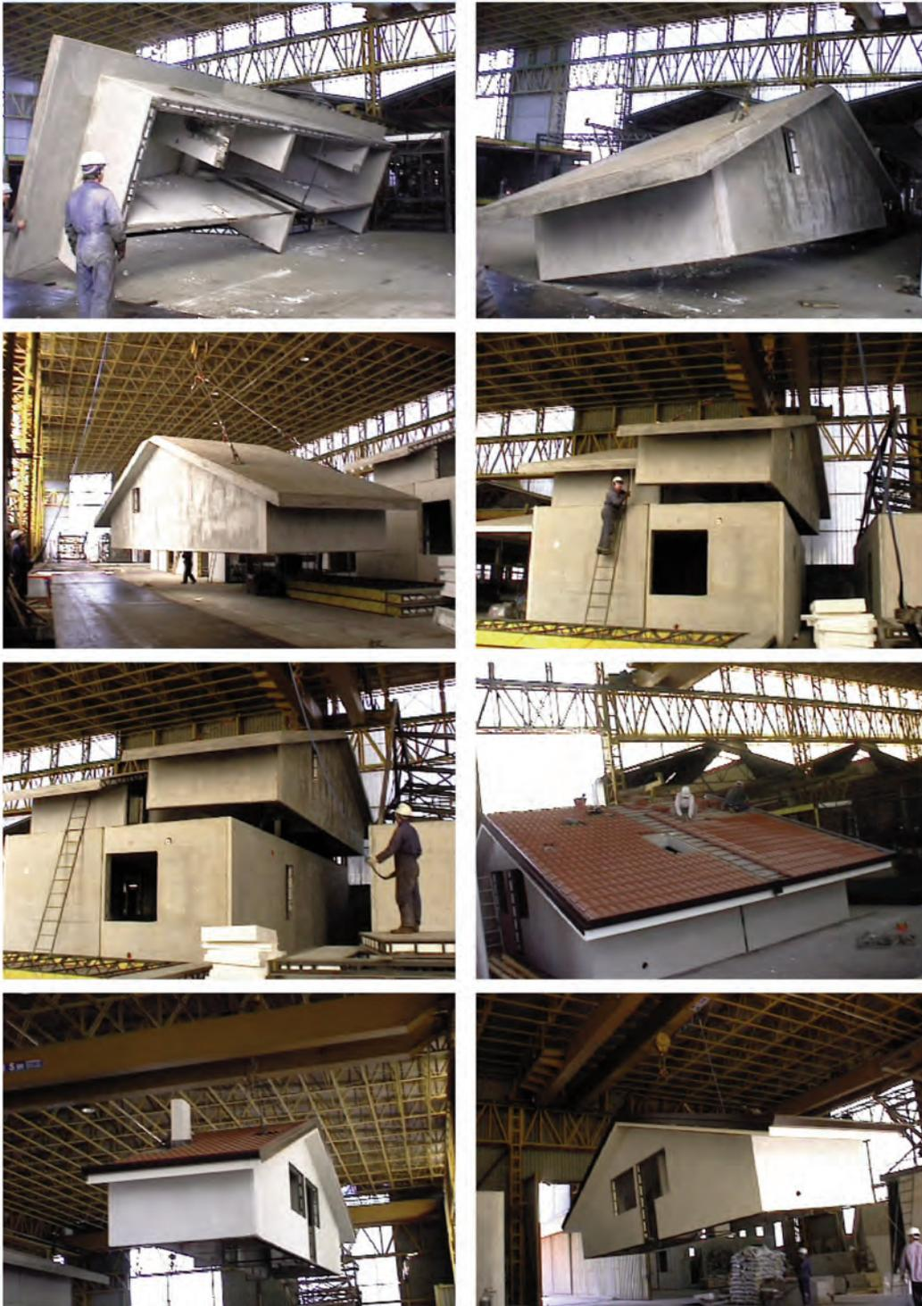
*B 15 - Sformatura-ribaltamento e montaggio elementi mansarda che vanno a completare la casa UNO2000*
