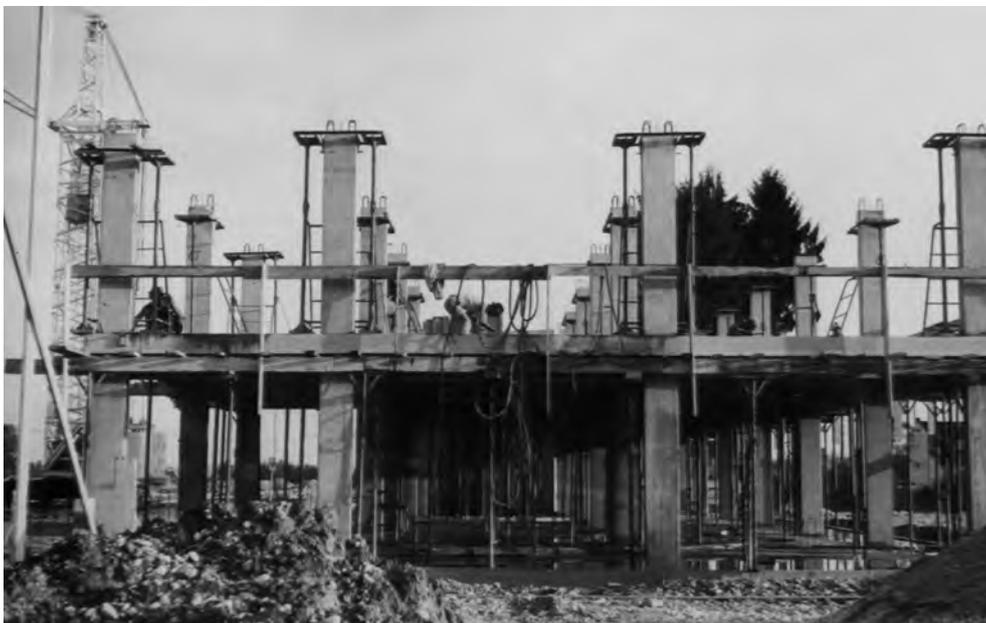
*A.34 - Qui viene illustrato l'impiego delle mensole studiate espressamente per sostenere gli impalcati di travi e solai utilizzando come rigido sostegno pilastri in c.a. realizzati il giorno prima*
