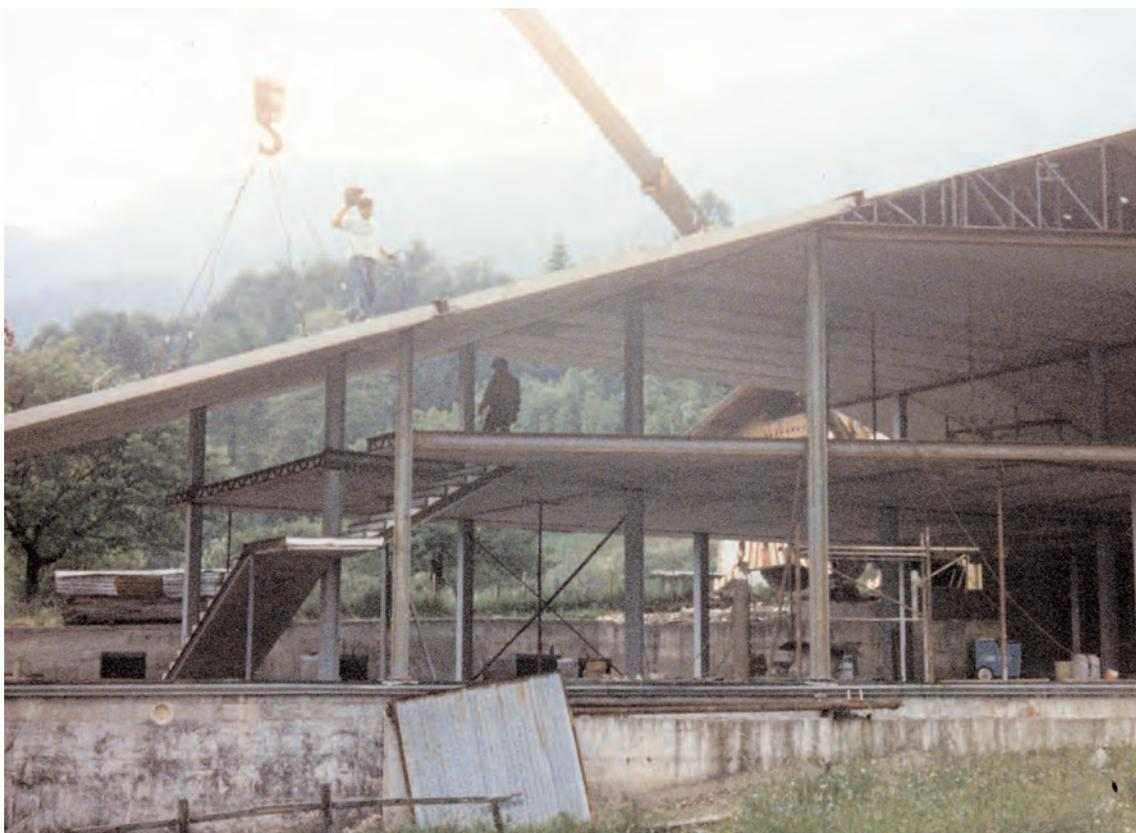
*B.35 - Struttura portante in ferro in combinazione con solai misti in ferro-cemento realizzata a Domegge di Cadore (BL)*
