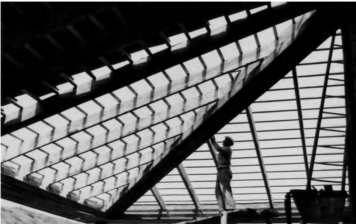
*A.10 - Qui vediamo la posa in opera dei travetti prefabbricati in cemento nei solai e nella copertura del porticato perimetrale alla fornace Rizzato di S. Daniele. Siamo nell'anno 1950*
