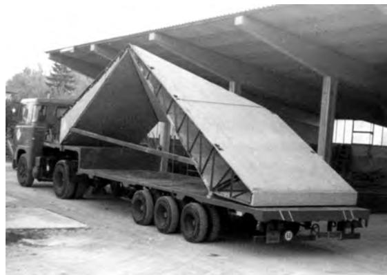
*A.68 - Dall' alto: Pannelli cassero con plinto continuo di fondazione incorporato, il montaggio dei muri perimetrali in un piano seminterrato e la copertura a doppia falda con intercapedine*
