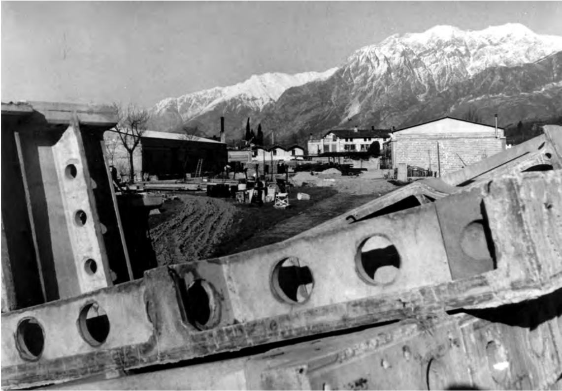
*A.20 - Elementi prefabbricati realizzati su progetto dell'Arch. M. D'Olivo nel primo tentativo di realizzazione della casa tubolare nell'anno 1955*
