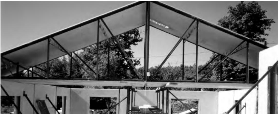
*A.64 - La struttura orizzontale, quella verticale e la copertura nel sistema Semiblock*
