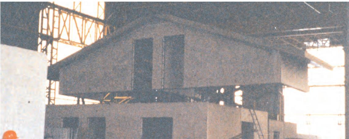
*B.18 - Sformatura, ribaltamento e assemblaggio elementi mansarda della casa UNO2000*
