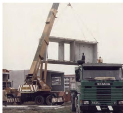
*A.69 - Sopra: Il block-volume dentro la dima nell'operazione di ribaltamento per la cementazione della seconda testata. Sotto: Bilancino costruito per la movimentazione in orizzontale che poi si è accantonato in quanto è un'operazione da potersi fare con i soli cavi dell'autogrù*
