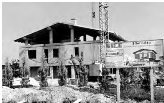
*A.51 - Le fasi di tracciamento e montaggio di una casa con struttura portante costituita da pilastri e travi con l'utilizzo dell' attrezzatura costruita alla S.I.C.E. Meccanica*
