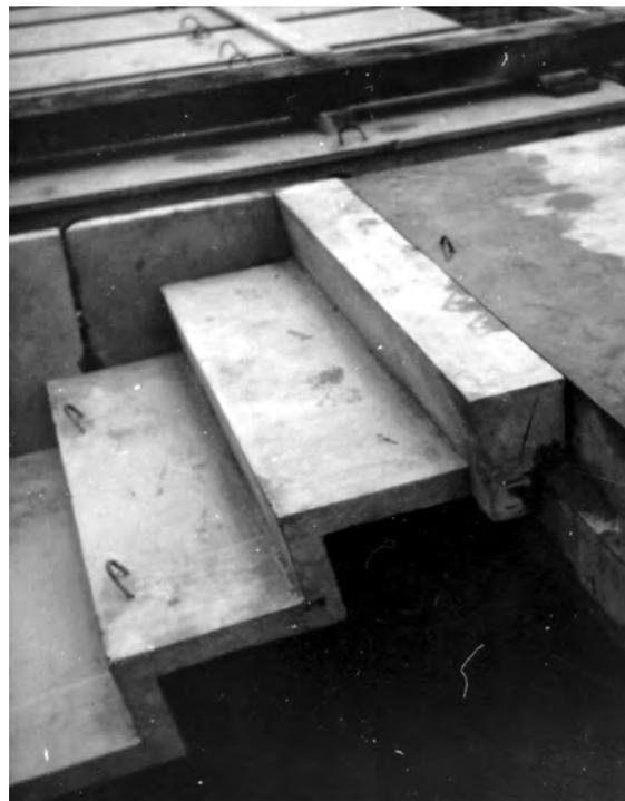
*A.26 - In alto a sinistra: La scanalatura nella parte inferiore del solaio su cui saranno poi infilati i pannelli di tamponamento. Le altre tre foto: Particolari del montaggio delle rampe scale nella parte centrale della Torre Zanier a Lignano Sabbiadoro*
