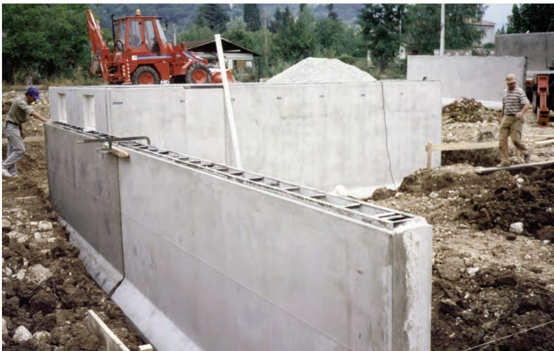
*A.47 - Il cassero in cemento di cui a brevetto n° 196688 usato per il piano seminterrato delle case E.M.E. Ursella con prolungamento inferiore a campana per i plinti*
