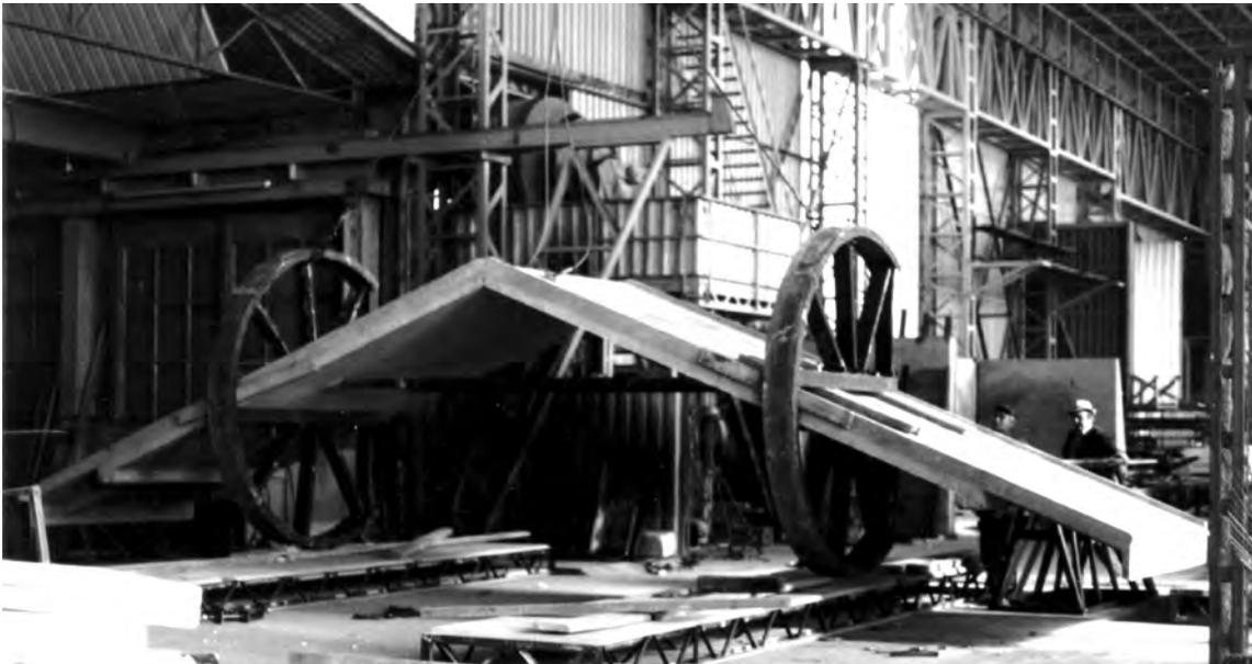
*A.66 - Il primo stampo con la ruota dentata necessaria alla rotazione del Block per il getto sui quattro lati e, foto in basso, il ribaltamento manuale dell' elemento di copertura a due falde*
