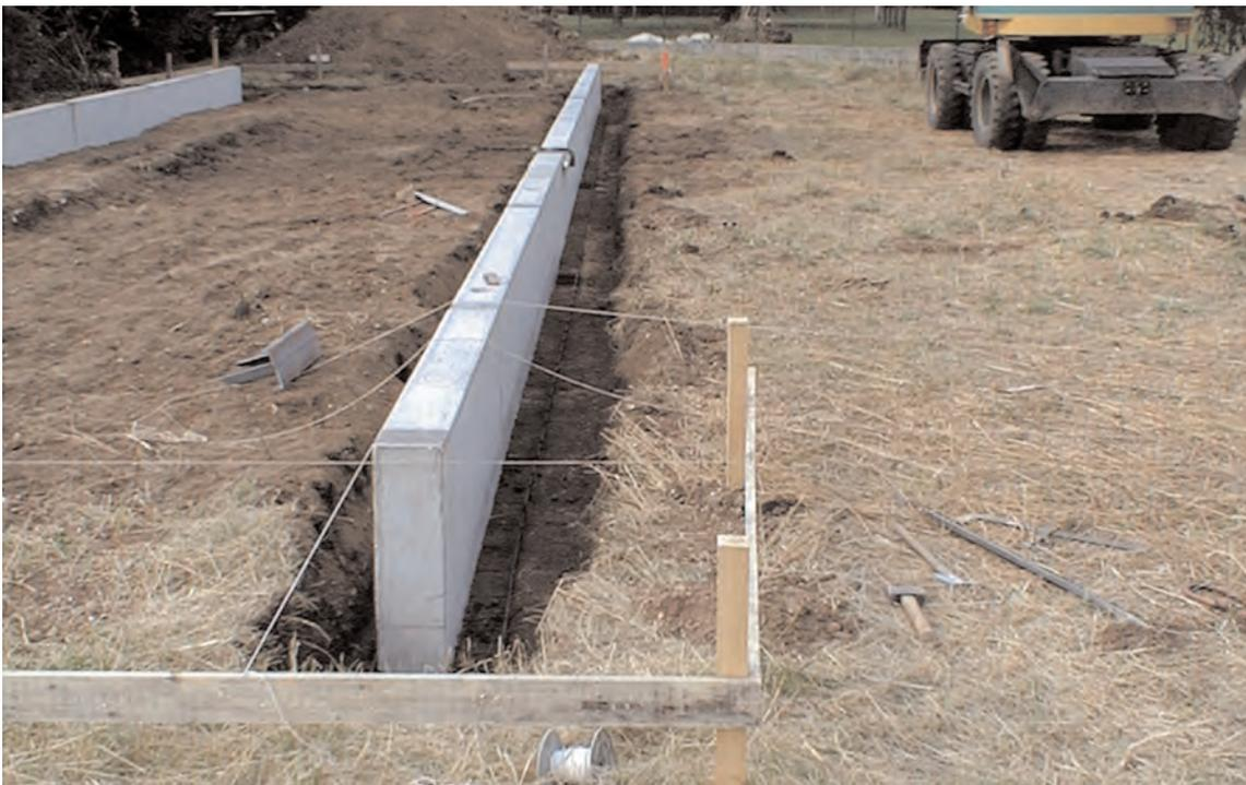
*B.14 - Travi di appoggio e fondazione delle case senza scantinato formanti il vuoto sanitario*
