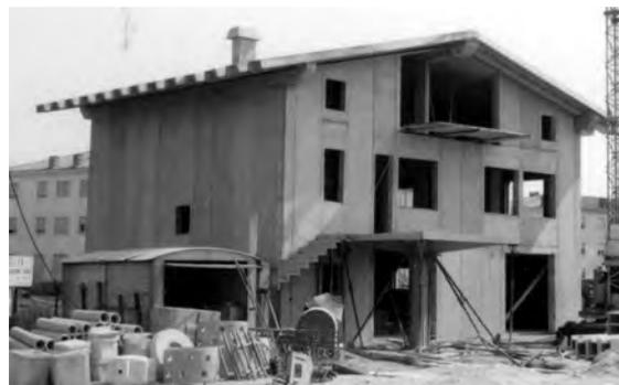
*A.52 - La sequenza di costruzione di una casa con l'utilizzo di pannelli a guscio come struttura portante. Anche in questo caso tutta l'attrezzatura per il montaggio era stata realizzata dalla S.I.C.E. Meccanica*
