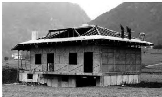
*A.62 - La sequenza di montaggio di una delle costruzioni con il Block-Volume prodotto in stabilimento e poi intonacato sul posto nei primi anni dopo il terremoto del 1976*
