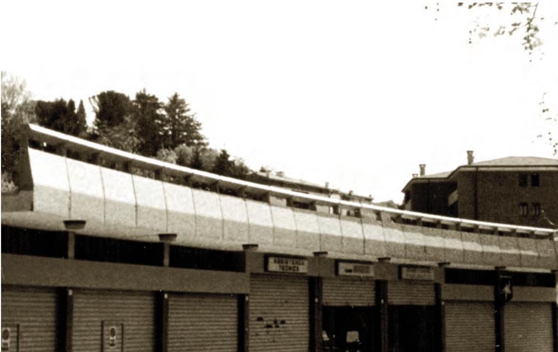
*A.06 - Nella foto sopra: Tombe nel cimitero di Buja realizzate con elementi prefabbricati. Sotto: Il parapetto realizzato con elementi prefabbricati nella piazza del mercato di Buja*
